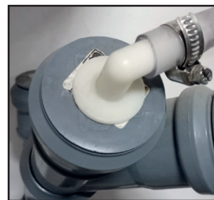
Pripojenie ku kanalizácii
