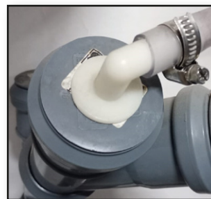
Pripojenie ku kanalizácii
